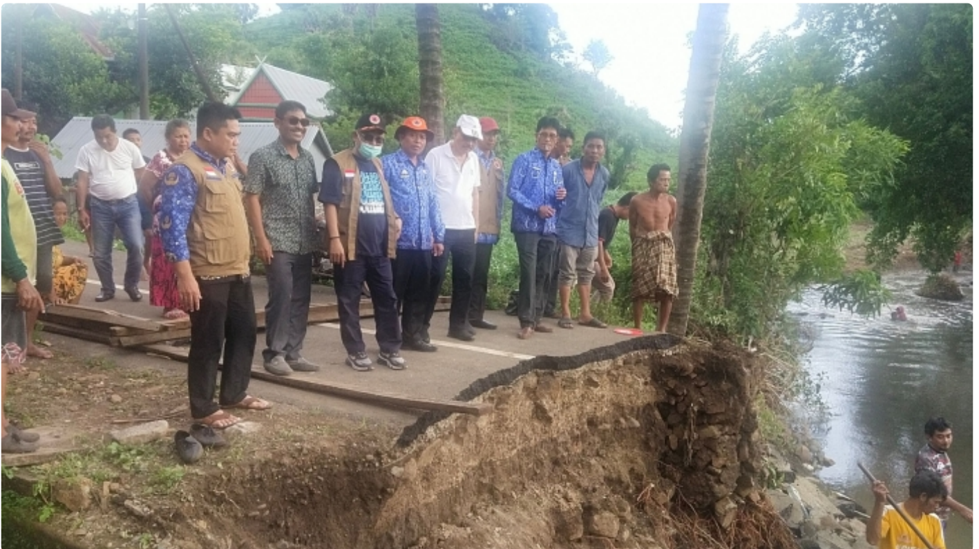
Plt. Kadis PUPR Muh Jafar Abbas dan Kadis BPBD Jeneponto, Ikrar Ishak Iskandar Pantau Kondisi Jembatan Runtuh di Desa Bulusuka
